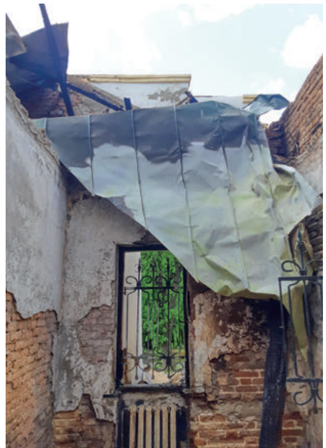
«Кімната Сковороди» Ліва перегородка з сучасної цегли на цементному розчині, фото В. Лопатька, 2022 рік
