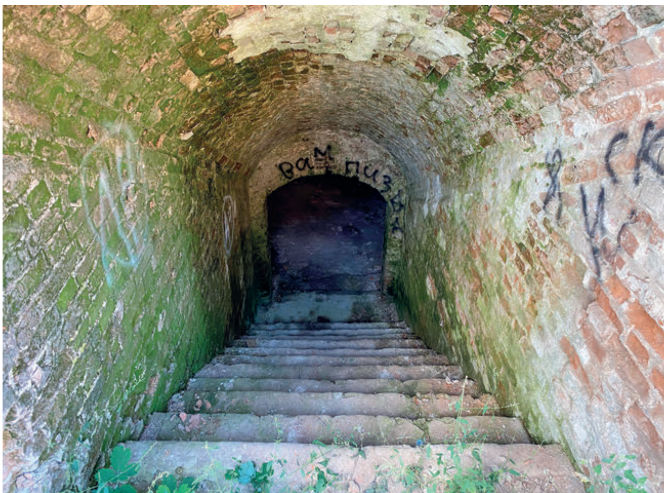
Вхід до підвалу під будинком Щербініних, фото А. Парамонова, 2021 рік
